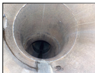
配管内仕上がり状況
